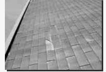
外壁：石綿含有仕上げ塗材(塗料)
